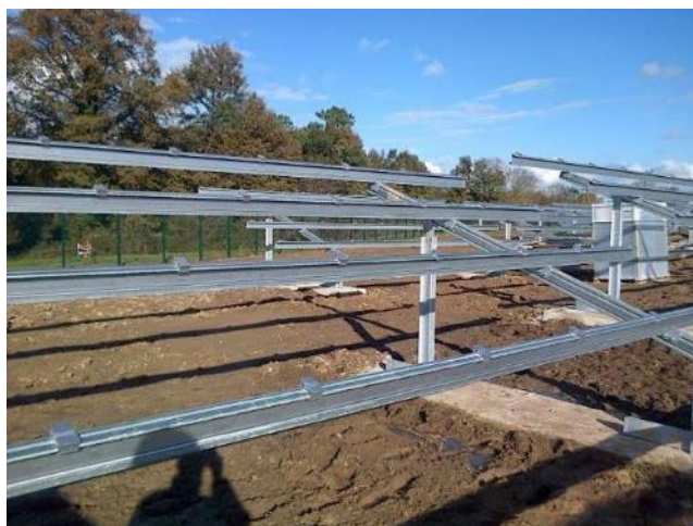
Figure 29 : Exemple de chantier de construction – Pose des structures
