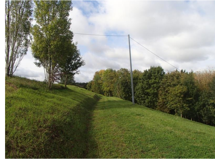
Prise de vue 14 : Vue du chemin en pied de dôme au nord du site
