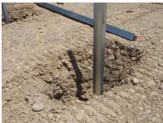
Figure 17 : Types de fondation - pieux battus (Source : Guide MEDDTL 2011 – NCA, 2015)
