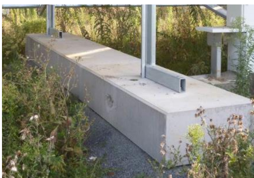
Figure 18 : Types de fondation - semelle béton (Source : Guide MEDDTL 2011 – NCA, 2015)
