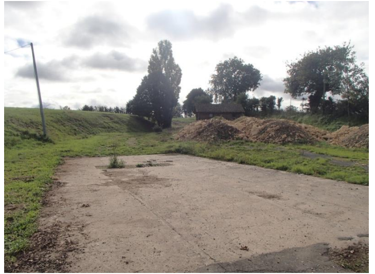
Prise de vue 2 : Ancienne aire de lavage
