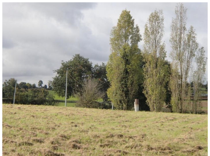
Prise de vue 12 : Ligne, poteaux électriques et haie sur le site
