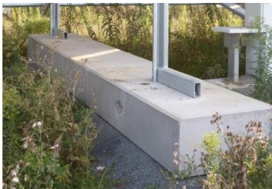
Types de fondation - pieux battus (gauche) et semelle béton (droite) (Source : Guide MEDDTL 2011 – NCA)
