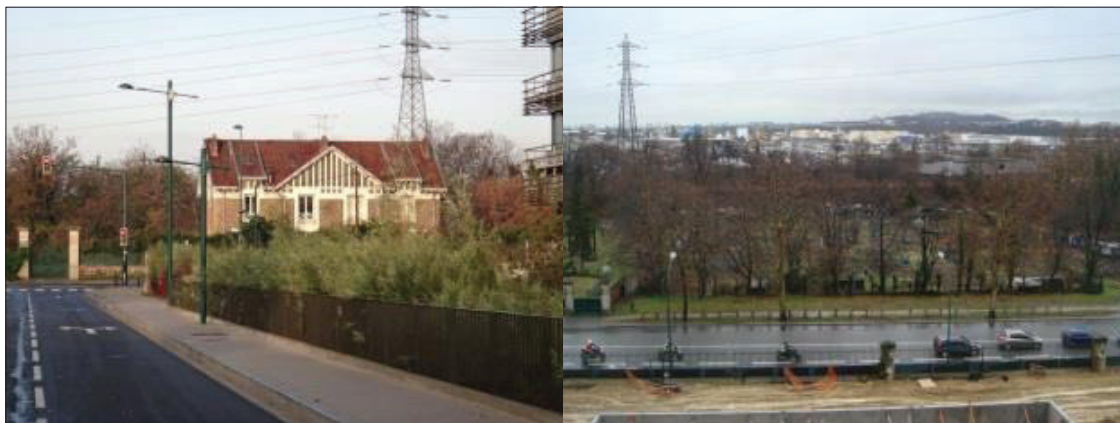
Photo 1 : Vue de la ligne à haute tension
