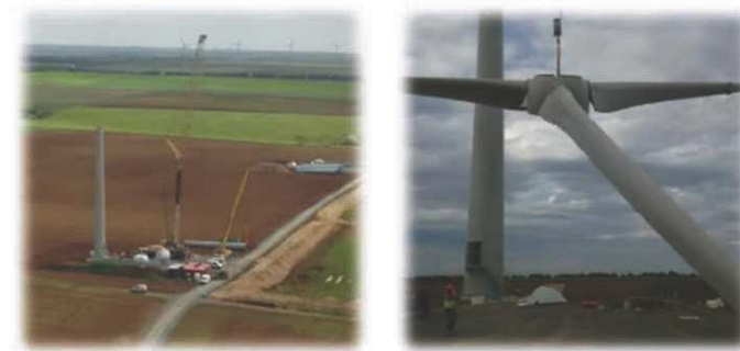
Figure 17 : Montage du mât (à droite) et levage du rotor (à gauche) (Source : ENERCON)
