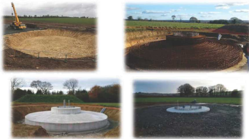
Figure 16 : Mise en œuvre d'une fondation (Source : ENERCON)
