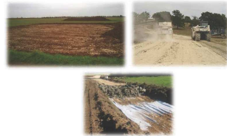
Figure 15 : Étape de création des pistes et plateformes (Source : ENERCON)
