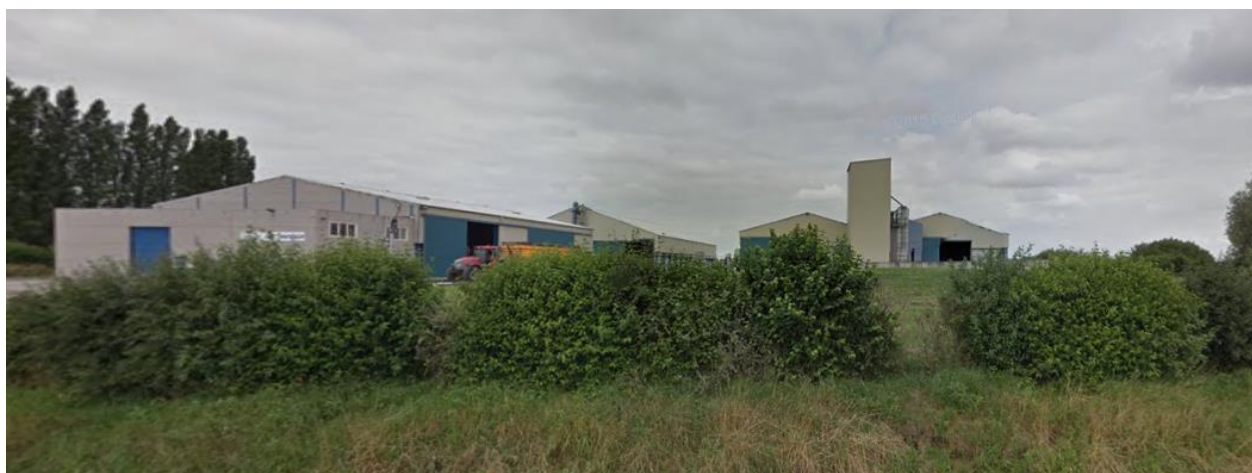
Vue des établissements SARL Luc JOURDAIN à partir de la RD 122, source : GOOGLE Street View
