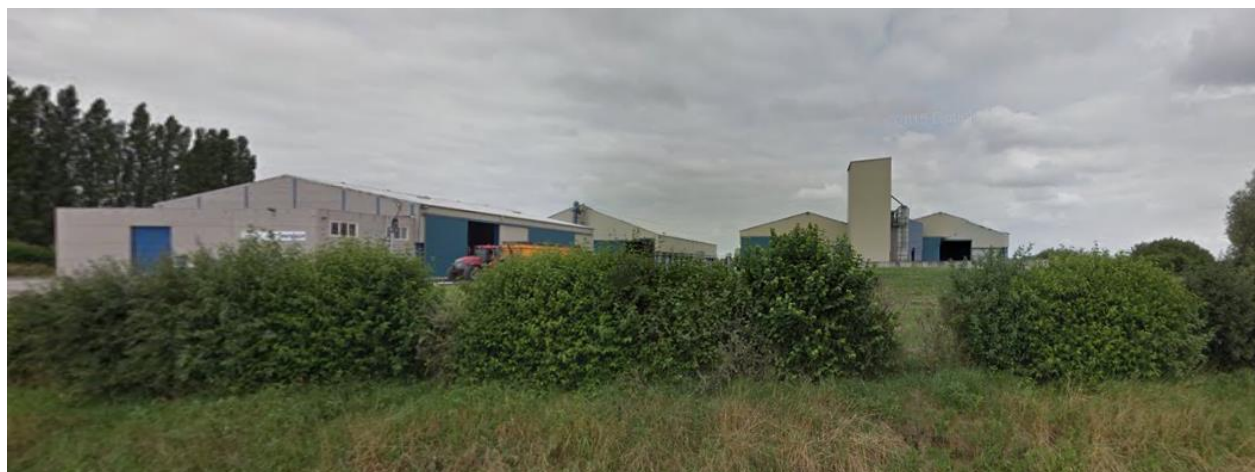
Vue des établissements SARL Luc JOURDAIN à partir de la RD 122, source : GOOGLE Street View
