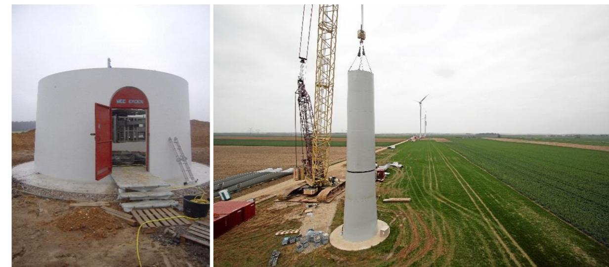
Figure 19 : Vue d'opérations d'assemblage du mât (chantier ENERTRAG)
