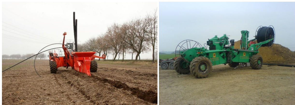
Figure 17 : Matériel de mise en place des câbles électriques (chantier ENERTRAG)
