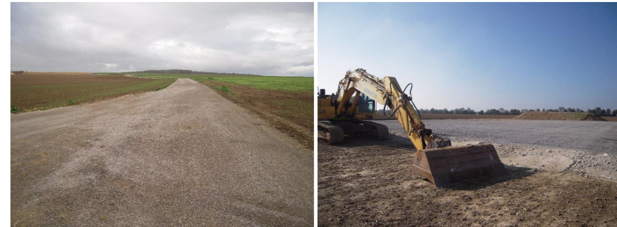
Figure 12 : Vues d'un chemin d'accès et d'une plateforme (chantier ENERTRAG)
