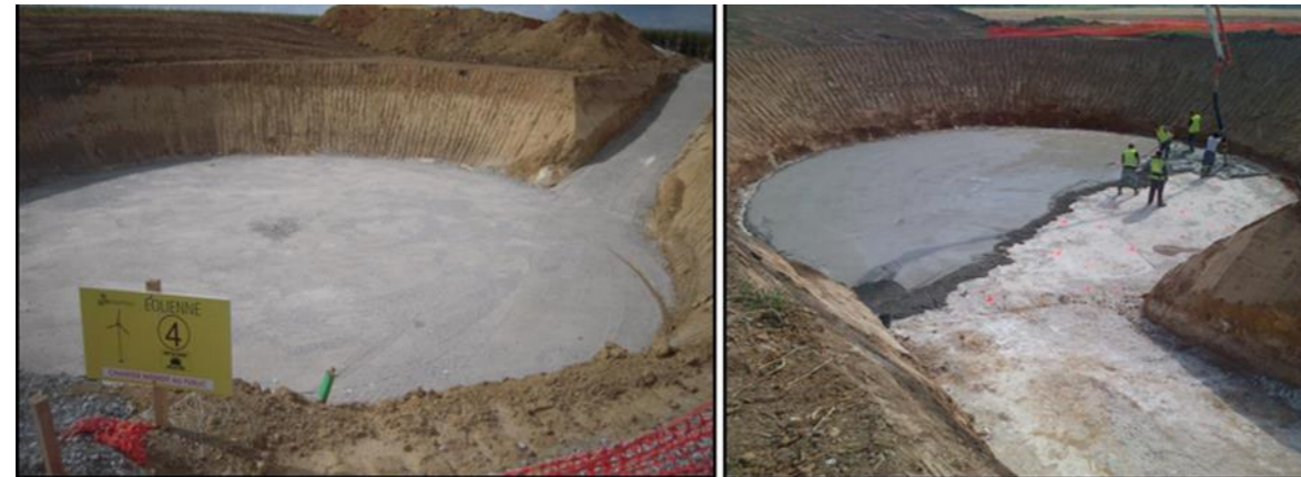
Figure 14 : Ferrailage et coulage des fondations (chantier ENERTRAG)
