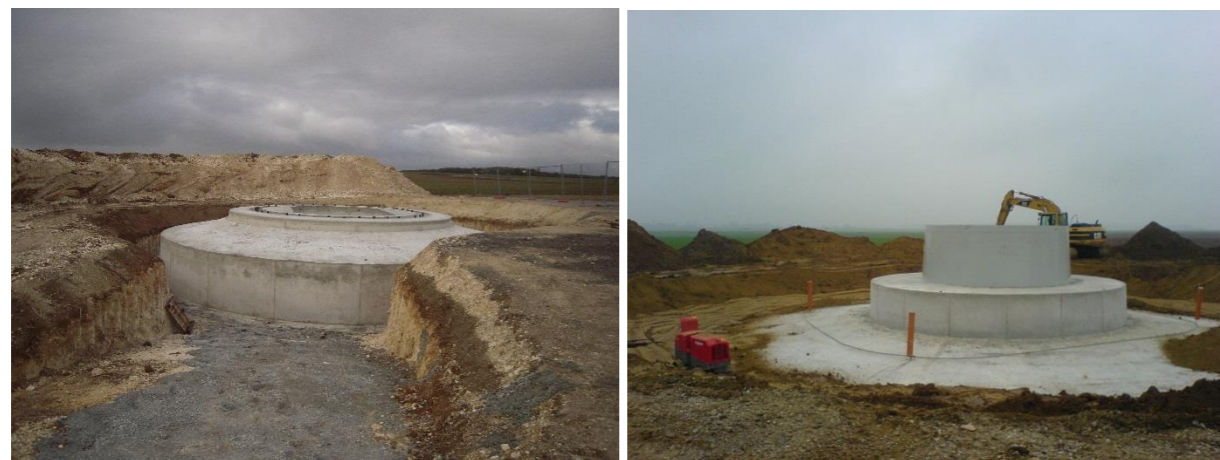
Figure 15 : Vue du massif béton d'une fondation (chantier ENERTRAG)
