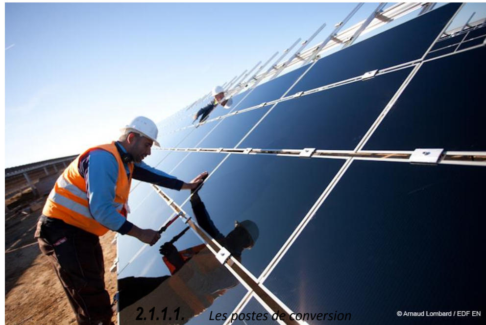
Photographie 2 : Illustration de l'espace inter module (Chantier de la centrale PV EDF EN France de Crucey)
