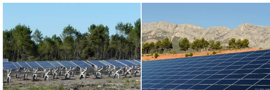
Photographie 1 : Structures solaires (à gauche: les trackers de la centrale de Gabardan (40) qui suivent le soleil ; à droite : structures fixes à Puylobier (13)) - Source : EDF EN France
