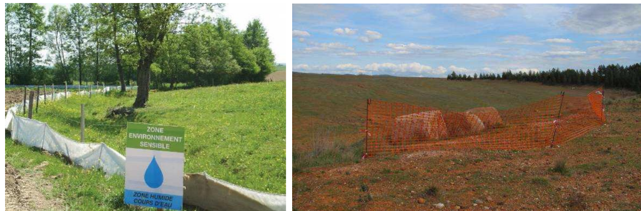
Photographie 4 : Signalétique et balisage (mise en défens) de milieux naturels à enjeux Source : EDF Energies Nouvelles
