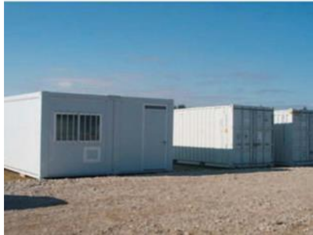
Photographie 3 : Installation de la base-vie Source : EDF Energies Nouvelles
