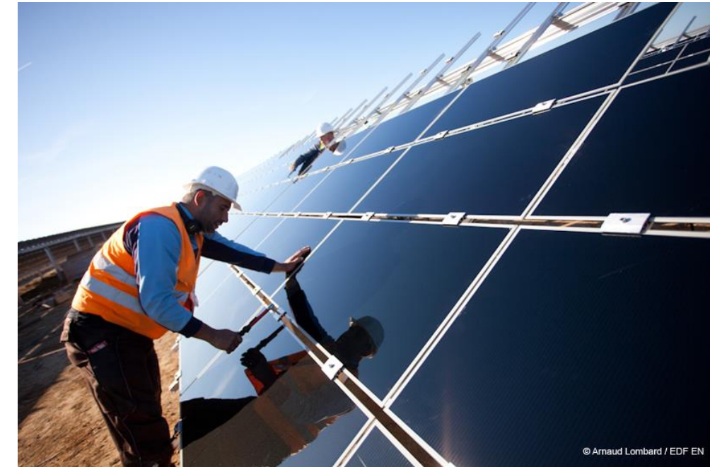
Photographie 2 : Illustration de l'espace inter module (Chantier de la centrale PV EDF EN France de Crucey)
