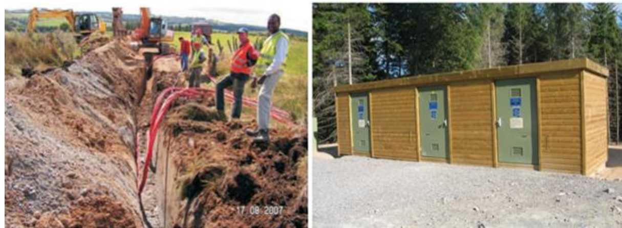
Photographie 7 : Déroulage et pose des câbles (à gauche), poste de livraison (à droite) Source : EDF Energies Nouvelles
