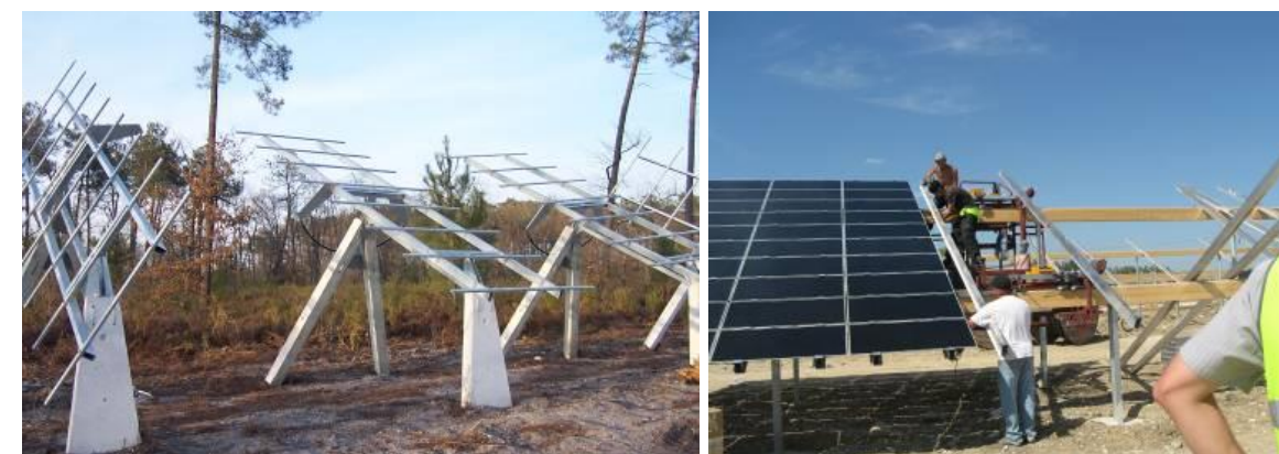
Photographie 6 : Montage des supports (à gauche), montage module (à droite) Source : EDF Energies Nouvelles
