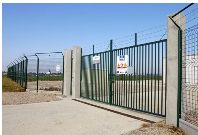
Exemple de clôture et d'accès de poste source Enedis
