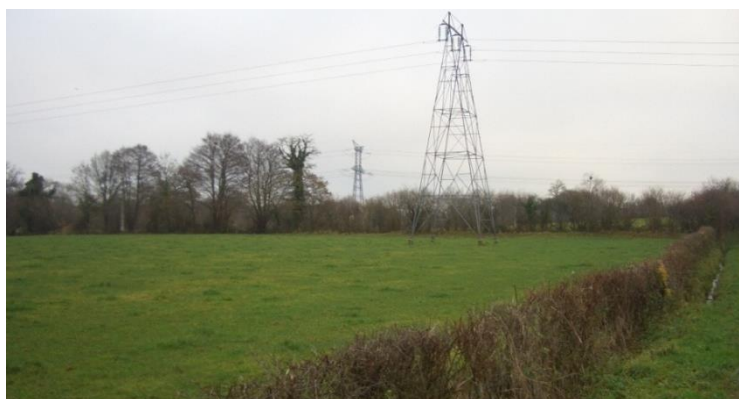
La ligne existante à 1 circuit 90 000 volts Agneaux – Villedieu (pylône 59 sur la photo) au niveau de l'emplacement 1A
