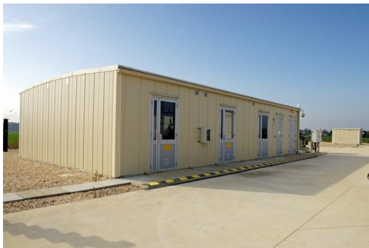
Exemple de bâtiment industriel de poste source Enedis
