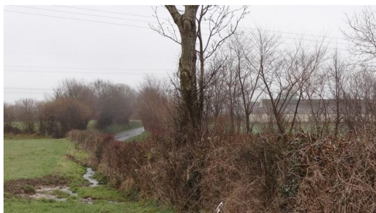
Le fossé bordant la RD29
