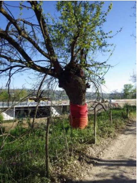
Illustration 7 : Exemples de mise en défens, de panneauage et de protection spécifique pour les arbres remarquables
