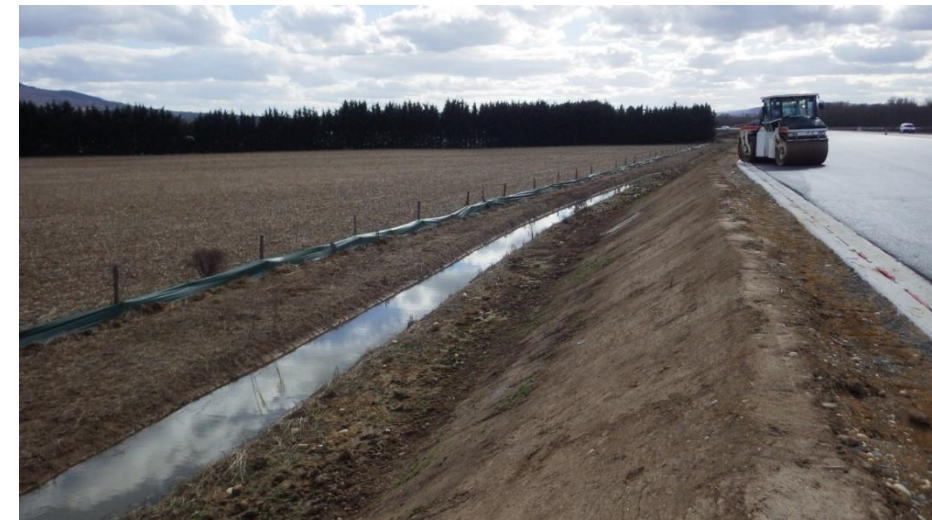
Illustration 9 : Clôtures anti-intrusion pour amphibien sur le chantier de l'A466 (Acer campestre)
