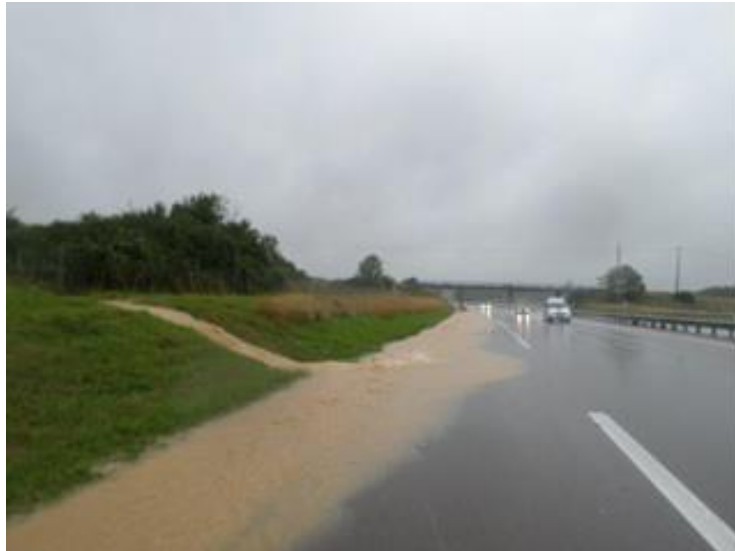
Illustration 4 : Dysfonctionnement du réseau de collecte
