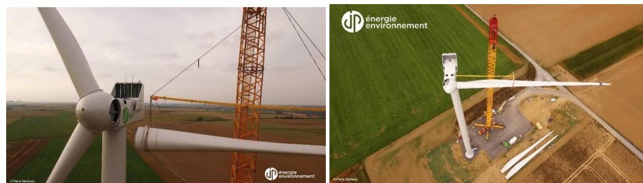
Figure 5 : Construction du parc de La Chaussée Brunehaut par JPee (2016)
