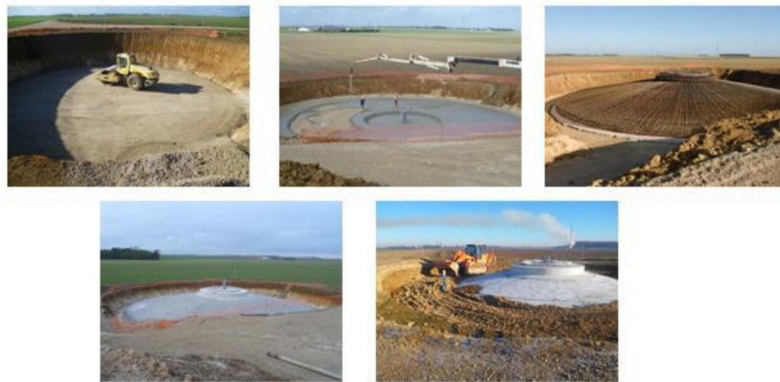
Figure 8 : Exemple de fondations (Source : JPee, 2018)
