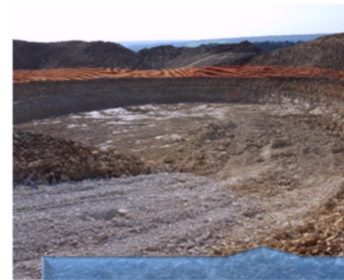
Fouille des fondations
