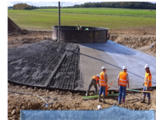
Coulage du béton
