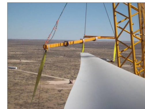
Figure 15 : Photos du chantier - assemblage des pales
