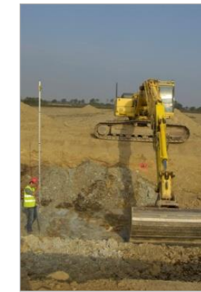
Fouille de la fondation
