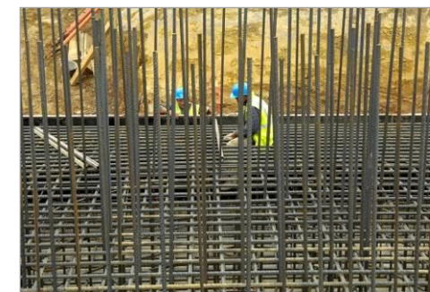
Ferrailage de la fondation
