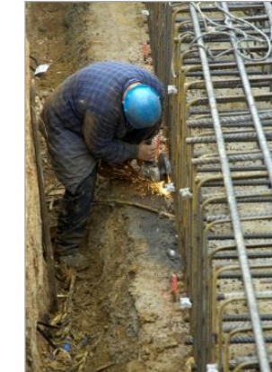
Préparation des fondations
