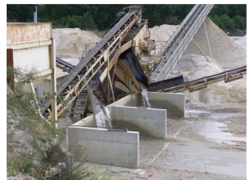
Vue sur l'installation (lavage des graviers)
