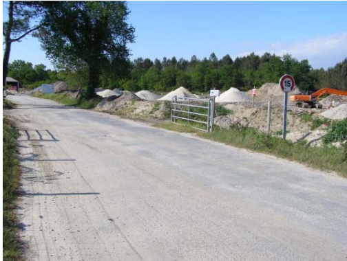
Piste d'accès revêtue
