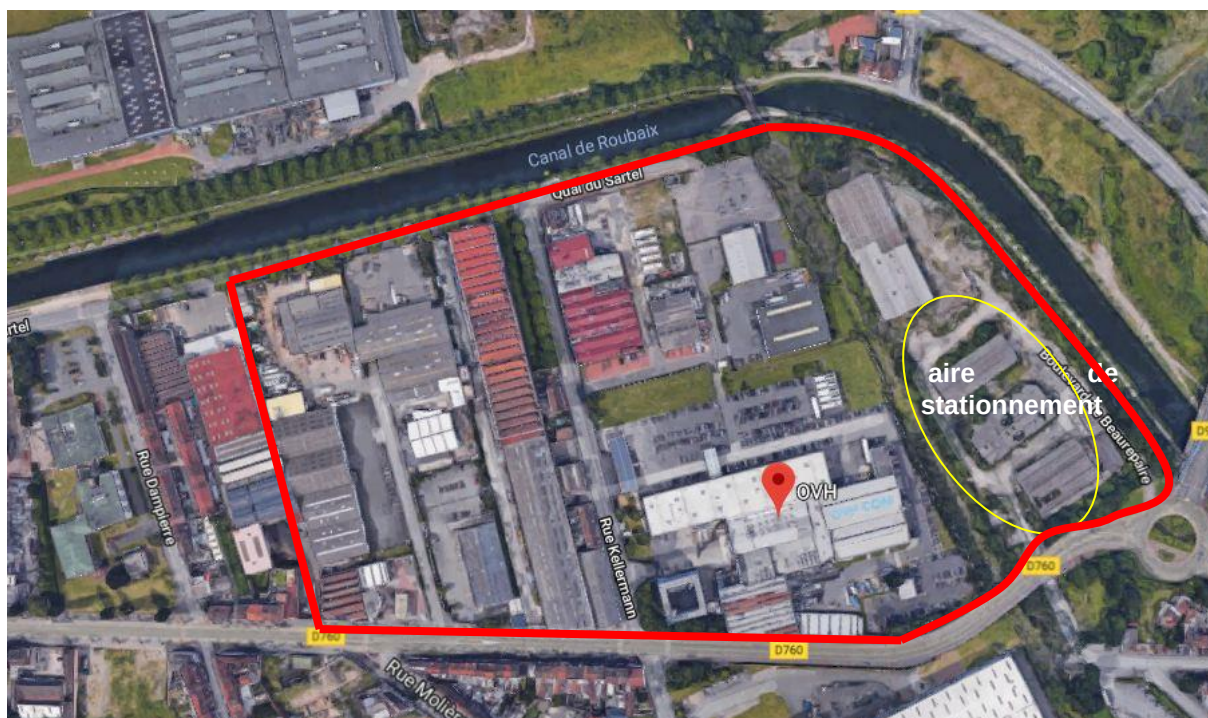
Figure 26 : Vue aérienne du site OVH – Roubaix
