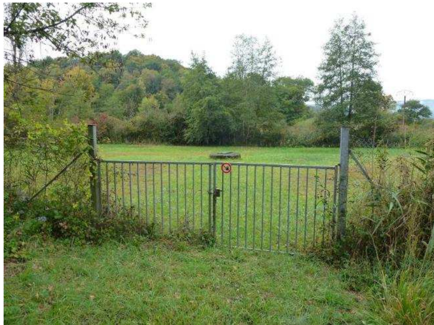
Puits de captage de Chazey Bons.
