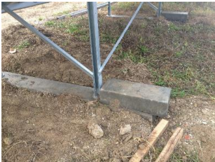
Figure 7 : Exemple de longrines bétons (source : Quadran, 2018)
