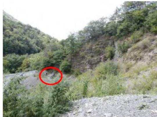
Falaise A5 et dépôt d'explosif protégé par un petit merlon à l'aval
