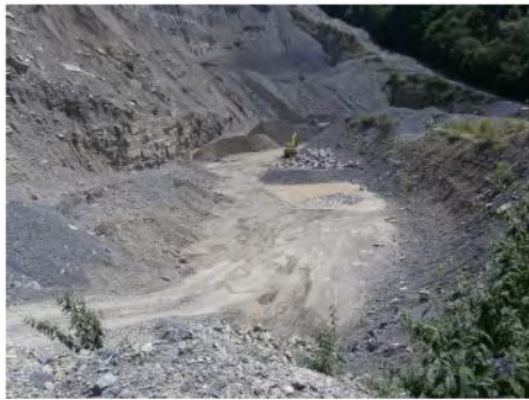
Merlon de protection réalisé suite à l'éboulement de 1995
