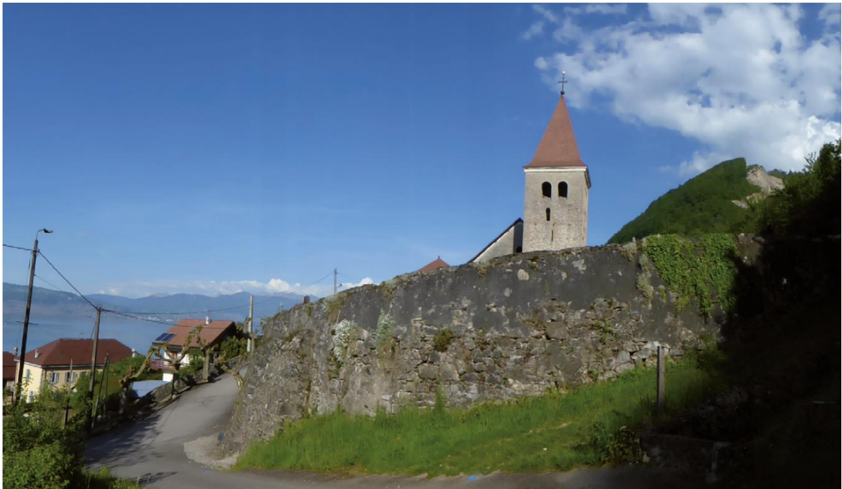
Figure 2 : Covisibilité entre le Prieuré et la carrière depuis la rive : ici le sommet de la carrière est perceptible et peut être assimilé à une falaise naturelle
