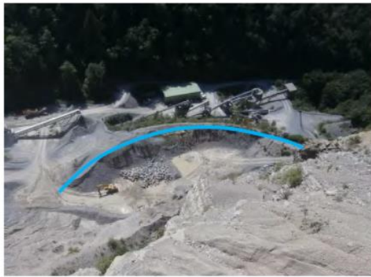
Merlon de protection réalisé suite à l'éboulement de 1995
