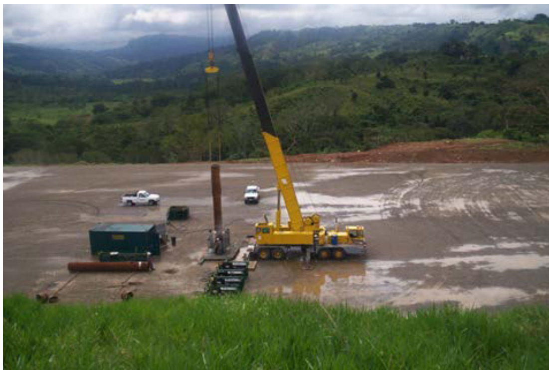
Figure 9 : Illustration d'un chantier de mise en place d'un tube conducteur par battage à l'aide d'une grue équipée d'un marteau (source : ORMAT).
