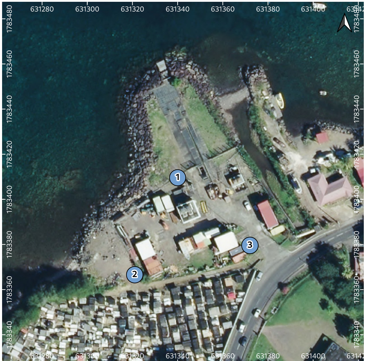
Figure 1 Emplacement des mesurages sur le site de la Géothermie Bouillante
