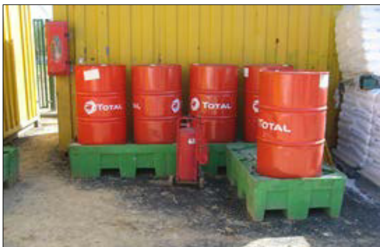
Figure 15 : Bacs de rétention et stockage d'huile sur un chantier.
