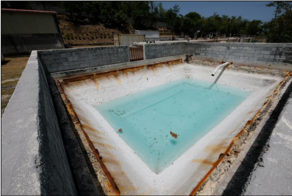
Figure 6 : Bassin de rétention bétonné sur la plateforme des puits actuelle destiné à recueillir le fluide géothermal déchargé durant les phases transitoires d’ouverture et de chauffe des puits, et de maintien en température. (Il sera également utilisé lors du test de production du puits BO-12).
