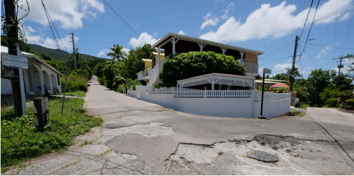
Figure 12 : Vue du Chemin Descoudes qui est la voie d'accès au chantier de forage du puits BO-12.
