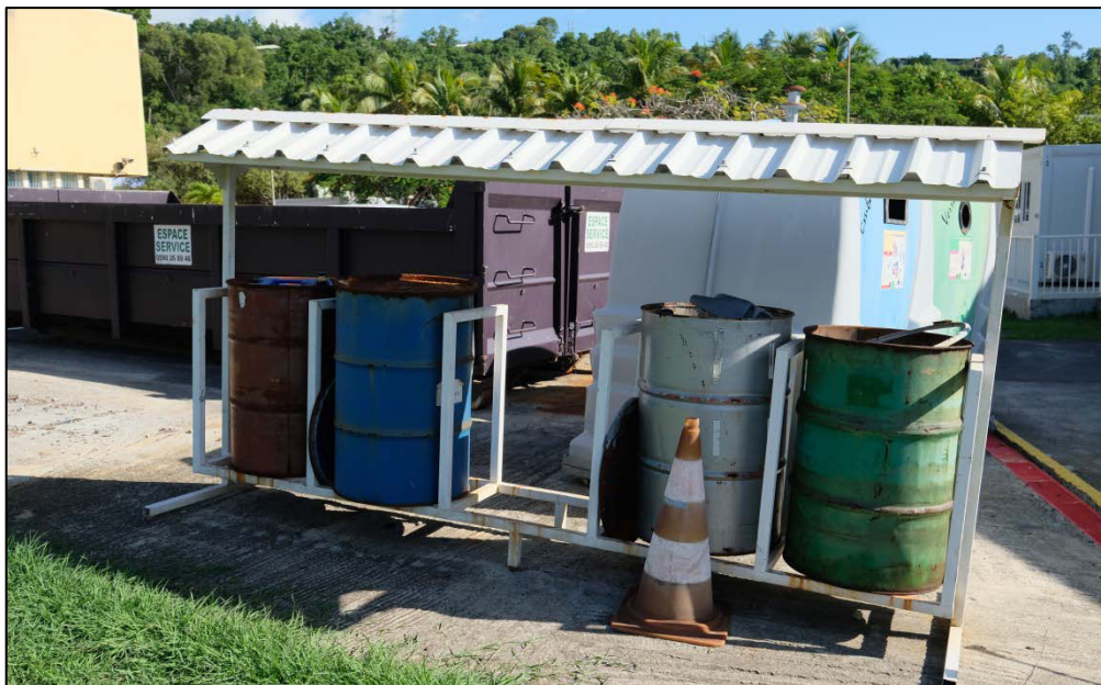
Figure 14 : Illustration du tri des déchets industriels banals tel qu'il est appliqué sur le site de la centrale et qu'il sera appliqué sur les chantiers de forage.
