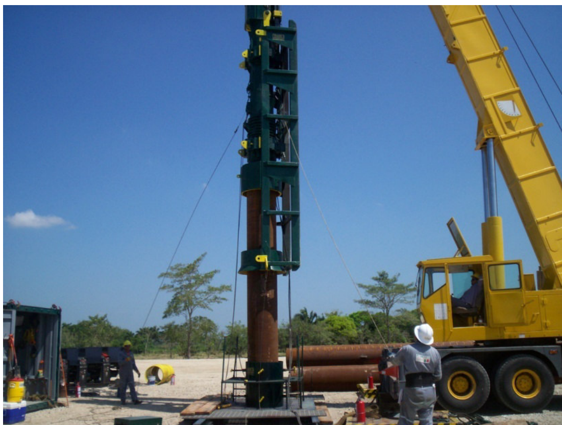
Figure 10 : Illustration d'un marteau enfonçant un tube conducteur (source : ORMAT)
