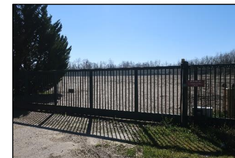
Portail de la zone B du site Source : Artifex 2020
