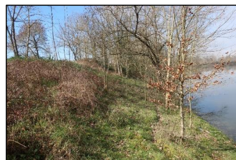
Berges aux pentes douces Source : Artifex 2020
