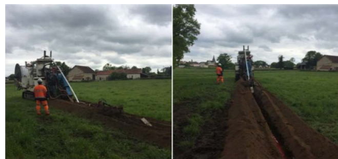
Figure 33 Exemple de chantier d'enfouissement d'un réseau électrique en terres agricoles
