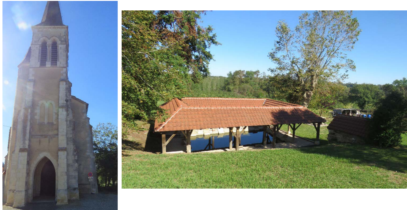
Figure 20 Eglise Saint-Michel au lieu-dit « Berrit » sur la commune de Cazeneuve et lavoir sur la commune de Bretagne-d'Armagnac
