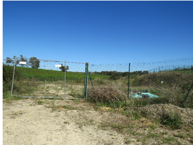
Figure 29 : station d'épuration de la commune de Bretagne-d'Armagnac
