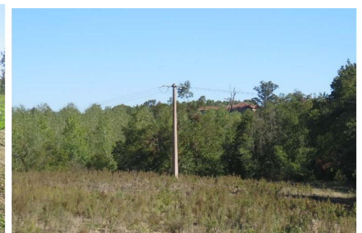
Figure 31 : ligne électrique HTA au sud-est de la ZIP
